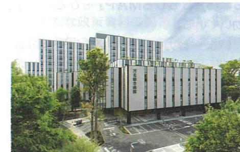
の工夫によって省エネを実現しました。例えば、西側に森を配置し、東西面に向いた窓を最小限にすることで建物の熱負荷を軽減。さらに、消費エネルギーの少ない設備機器を導入するなど、工夫をして実現できました。
