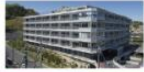
● 河北通橋クリニック
